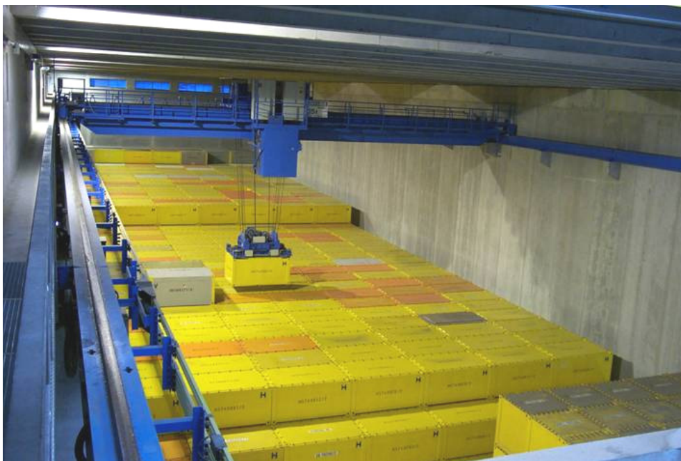
Abb. 4.1 Zwischenlagerung radioaktiver Abfälle mit vernachlässigbarer Wärmeentwicklung (Quelle: FZK)
