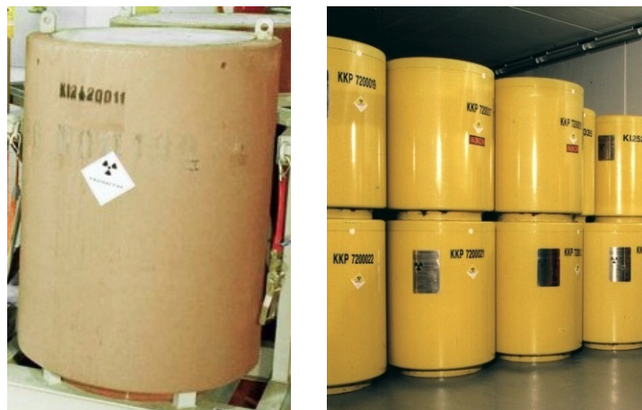
Abb. 4.2 Betonbehälter (links) und Gussbehälter (rechts) (Quelle: BfS)
