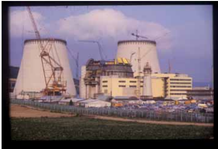
146,5 Meter werden die Kühltürme hoch, unten 105, oben 63 Meter breit.
